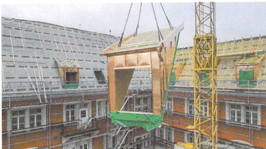
▲ Fertigaube am Haken: Die großen Elemente wurden auf der Baustelle einfach mit dem Kran vom Lkw gehoben und an den gewünschten Einbauort im Dach geschwenkt
