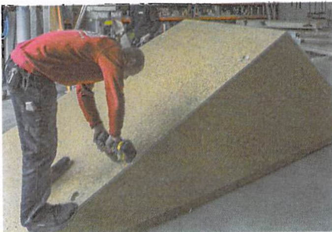
▲ Einmal in die richtige Position gebracht, ließen sich die Elemente ohne Probleme mit dem Akku-Bohrschrauber verbinden
