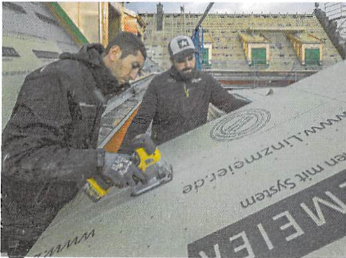
▲ Die Dämmplatten lassen sich mit handelsüblichen Werkzeugen schneiden, drehen und auf der anderen Seite von Grat oder Gaube wieder anlegen
