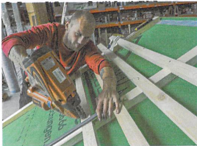
▲ Im nächsten Arbeitsschritt wurden auf dem Gaubendach Konterlattung und Lattung für die Biberdeckung montiert
