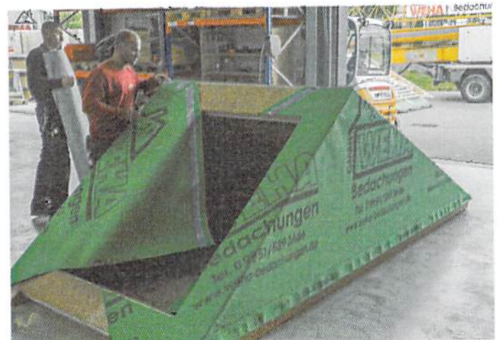
▲ Anschließend verlegten die Dachdecker in der Werkstatt eine Unterdeckbahn, um die Gaube später luftdicht anschließen zu können
