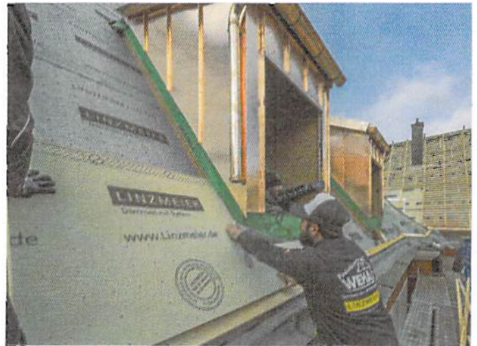
▲ Anschluss an die Fertiggauben: Auch hier war es von Vorteil, dass sich die Dämmplatten auf der Baustelle exakt zuschneiden lassen
