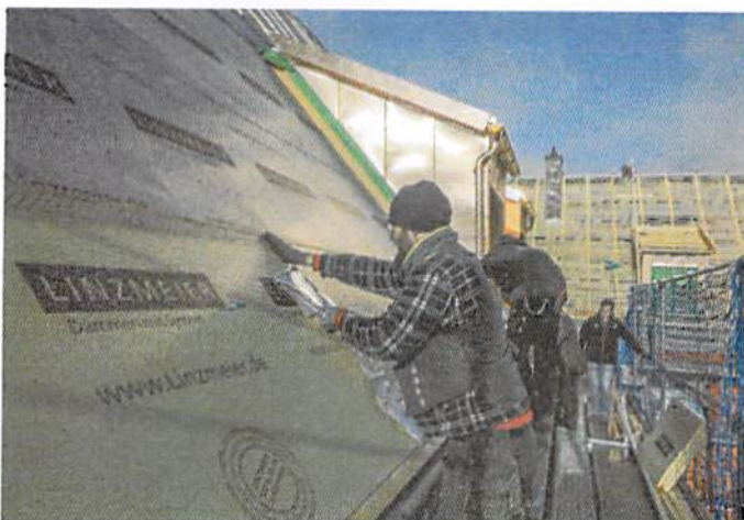
▲ Auf der Traufbohle startend, wurden die PU-Dämmelemente auf der Baustelle von unten nach oben verlegt
