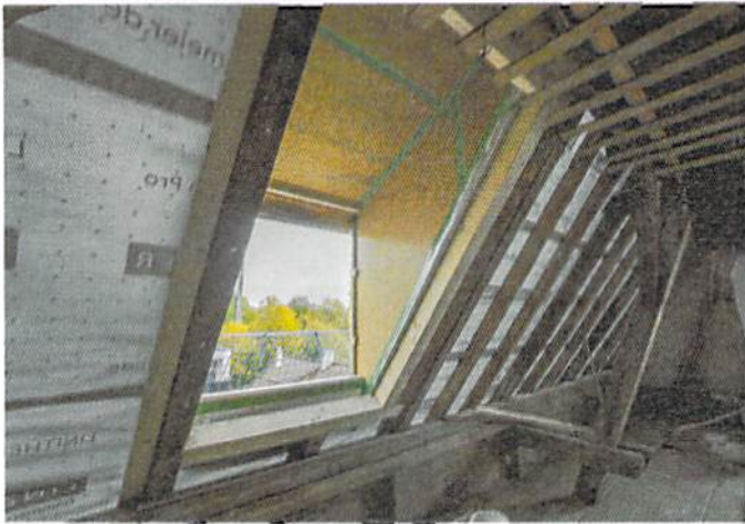
▲ Dank der Gaubenvariante mit integrierten Montageschwellen konnten die Fertiggauben direkt auf die Sparren gesetzt werden
